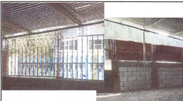
Foto 3: Fabricación e instalación de 4 ventanas-balcon de metal. Fabricación e instalación de 2 balcones de hierro en ventana
