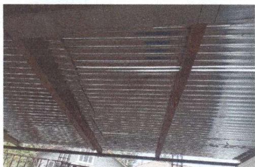
Foto 1: Sustrución de lámina, por lámina troquelada aluzinc calibre 26. Sustrución de estructura de soporte de madera, por metal
