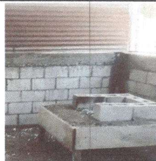
Foto 6: Sustrución de estufa rural (completa) incluye chimenea y plancha de metal
