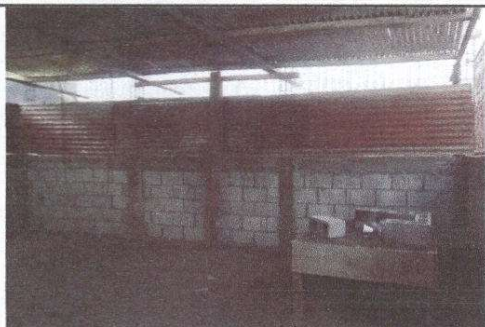
Foto1: Sustrucción de Muro de Lámina por muro de block
