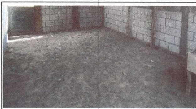
Foto 4: Piso (Sustrución de piso de torta de concreto)
